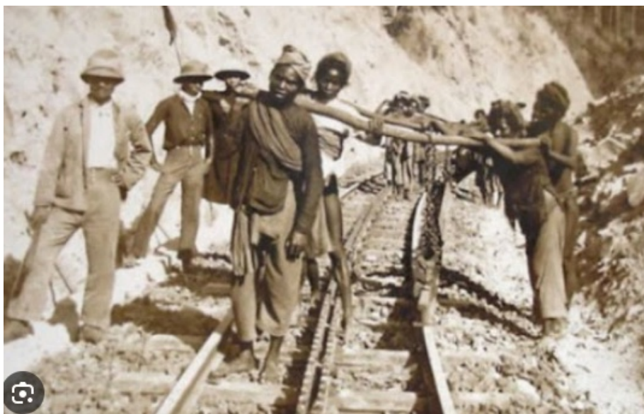
Construction chemin de fer Congo-Océan
