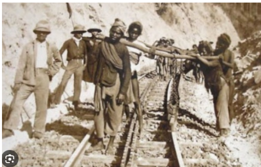
Construction chemin de fer Congo-Océan
